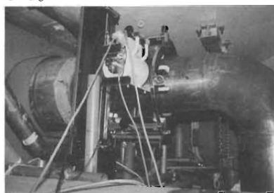
写真1 配管水平部分のスキュニング測定
